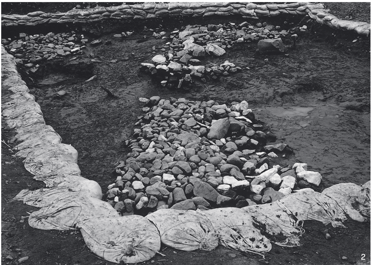
1. 四百町開旧堤防全景(上空より) 2. 四百町開旧堤防 石積み検出状況
