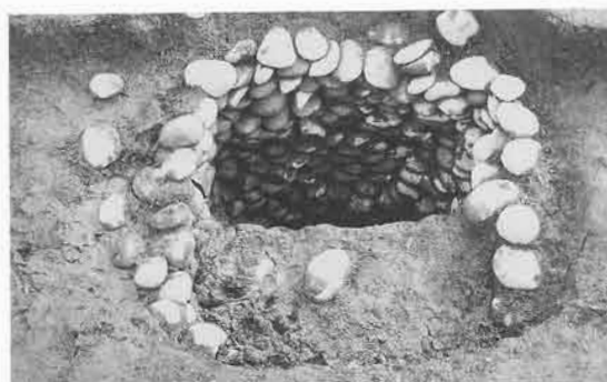
3号井戸 石積み状況
