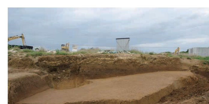
II地区 Cライン 西壁 D11グリッド (東から)
