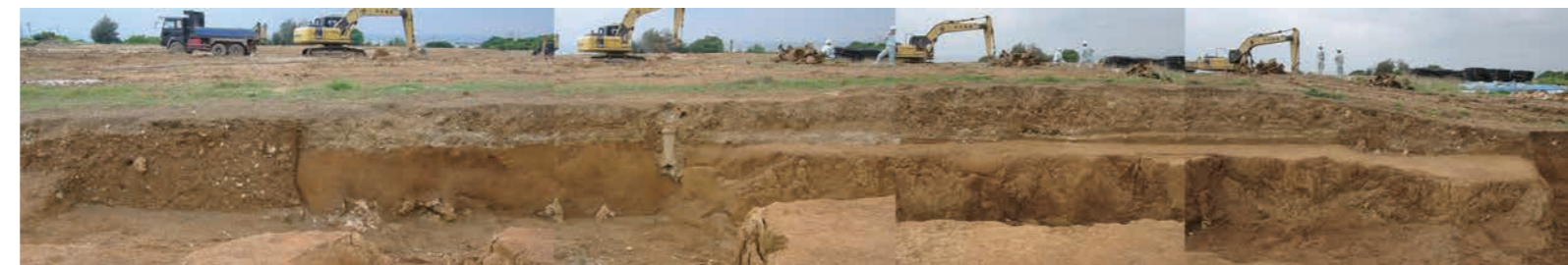
II地区 Cライン 西壁 G12グリッド (東から)
