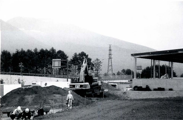
調査風景・表土除去作業（南西から）
