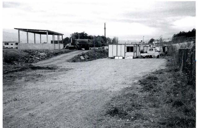
ハウス等設置・駐車場整地等状況（北東から）
