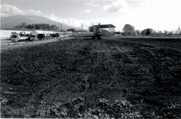
調査開始前状況（南西から）
