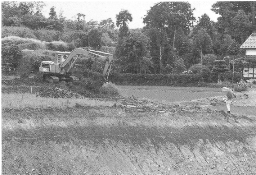
耕土排除作業
