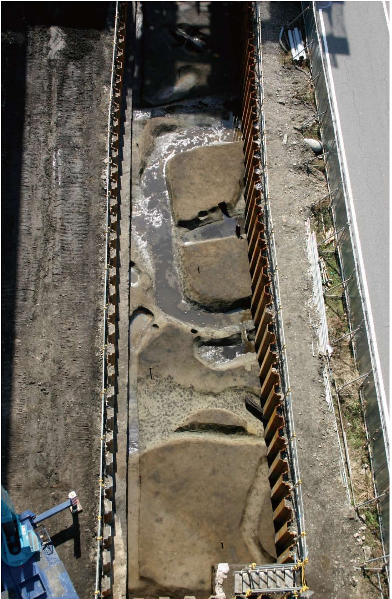
● 05Dd 区 - 調査区全景 SZ168 付近の加工面
