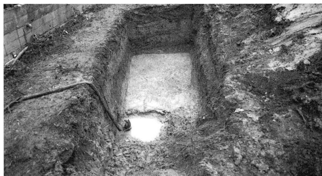
発掘区全景 (南から)
