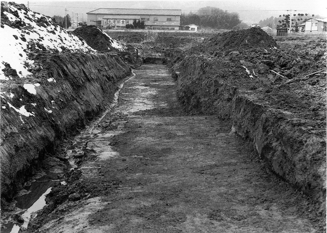
第3トレンチ（東から）
