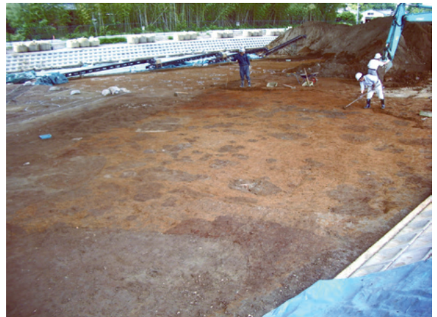
SB1005 検出状況
