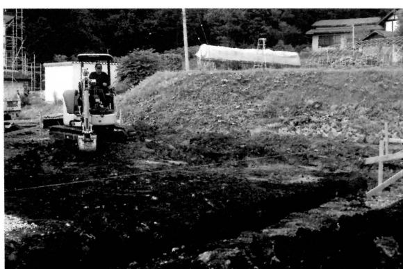
写真3 正徳寺遺跡工事立会
