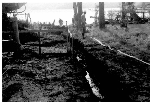
写真1 狐久保遺跡工事立会
