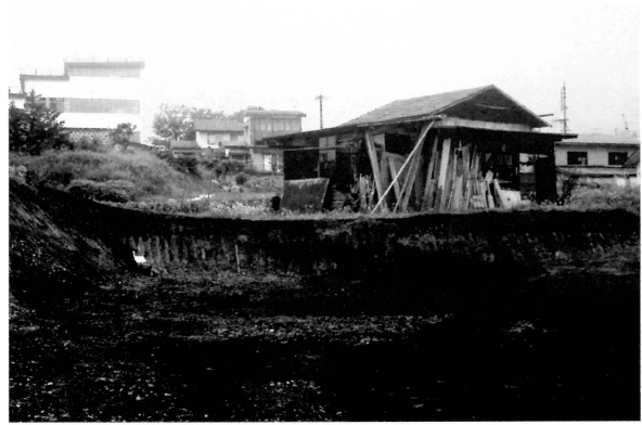
写真20 一里塚遺跡工事立会
