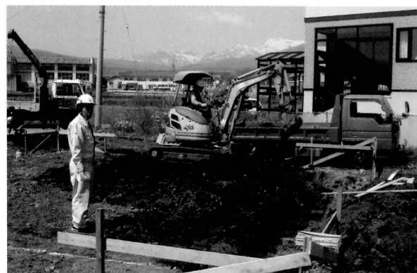
写真19 一里塚遺跡工事立会
