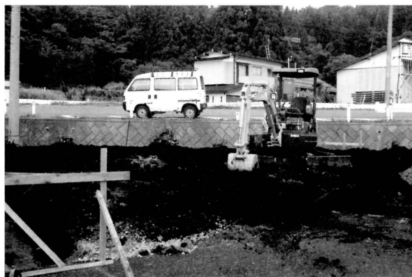
写真4 川久保遺跡（倉庫建設）
