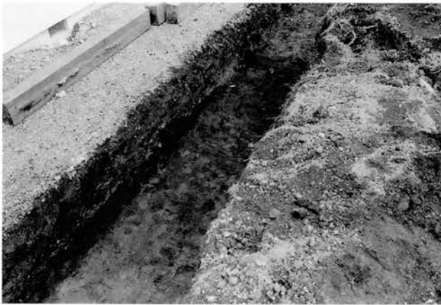
(5) 擁壁基礎② (東から)
