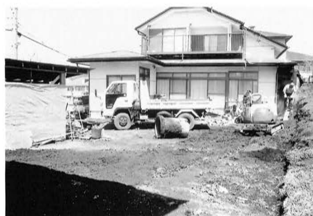
24-4 藤塚遺跡 (1) 調査区現況 (南から)
