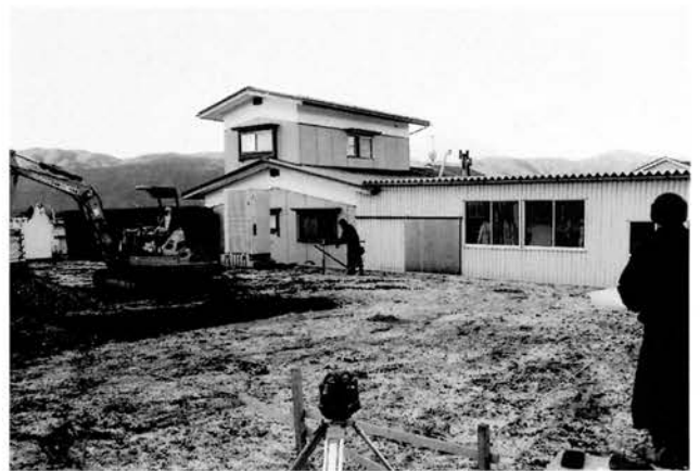
24-5 一本木遺跡 (1) 調査区現況 (東から)
