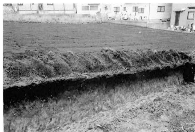
(3) 擁壁基礎土層断面 (北西から)
