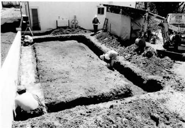
(7) 調査状況 (北から)
