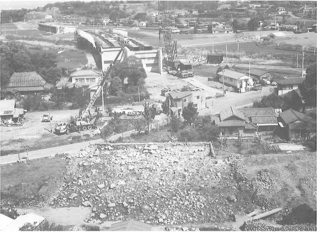
坂口館跡と建設が進む横断道
