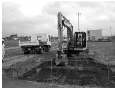
写真3 A地区表土掘削
