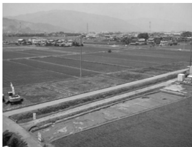
写真9 A地区調査区
