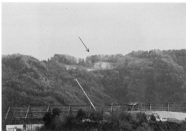
遠景（南西より）
