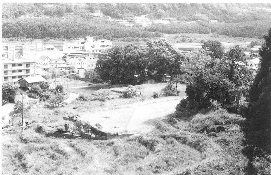
調査地全景(南から)
