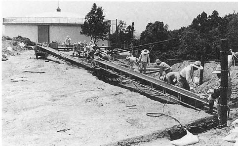
写真1 天神山遺跡 調査風景
