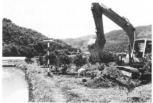
写真1 試掘調査風景
