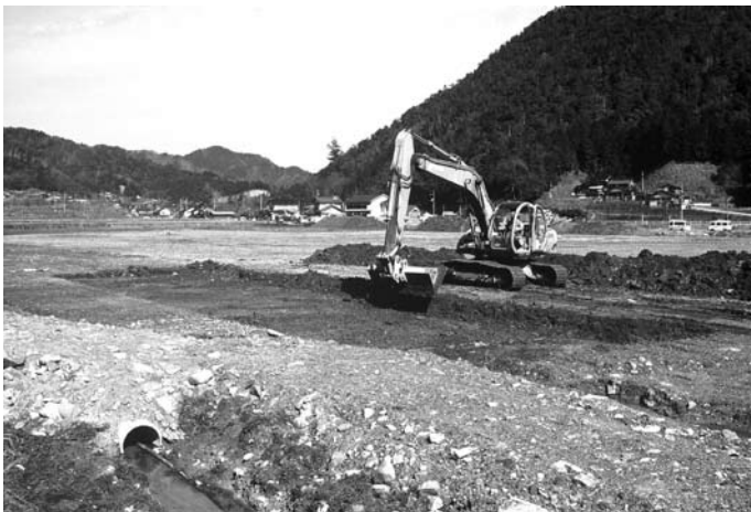
3区表土等除去工事風景（南より）
