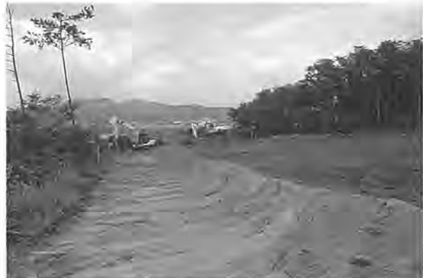
写真2 B区 表土剥ぎ風景
