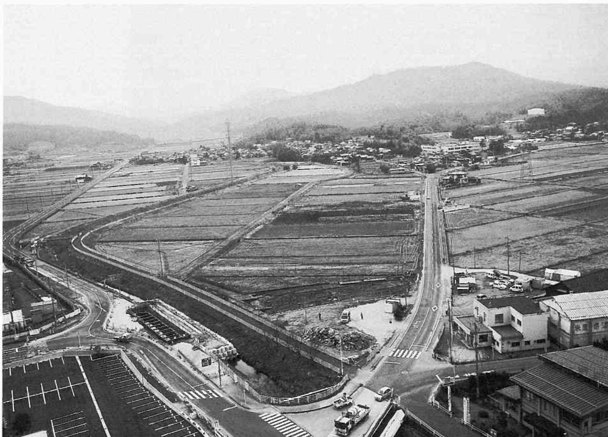
調査地遠景（北東上空から大路川および久末・古郡家集落を望む）
