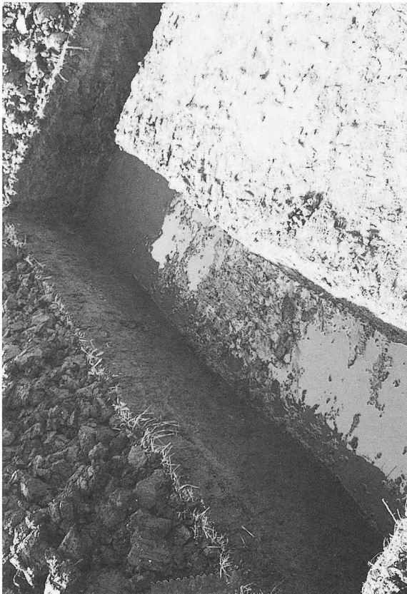
(1) 第 3 トレンチ完掘状況
