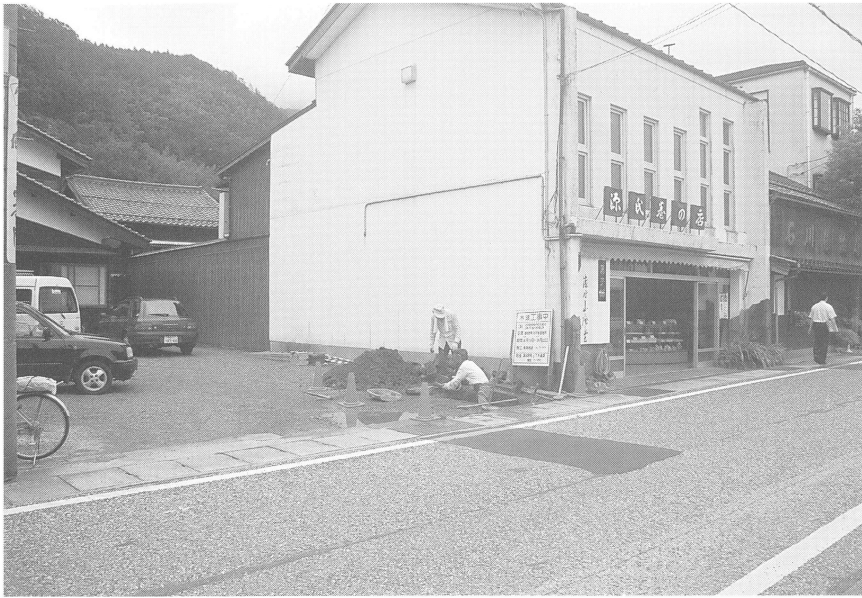
1. TP1(祇園町) 近景 (北西より)
