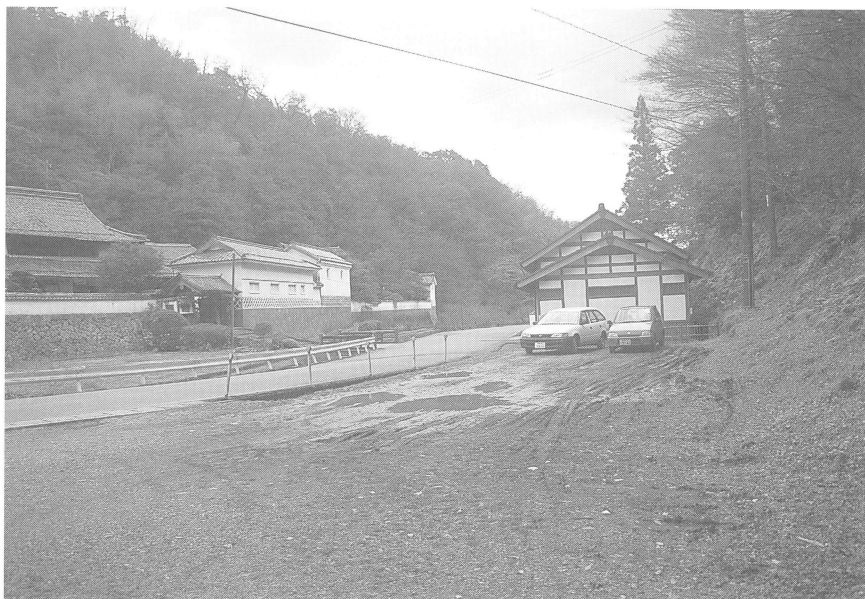
1. 調査区近景 (南西より)
