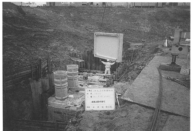
ポンプピット工事
