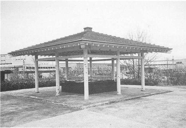
遺構全体模型覆屋
