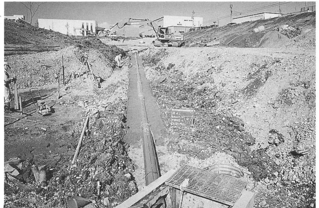
排水管理設工事
