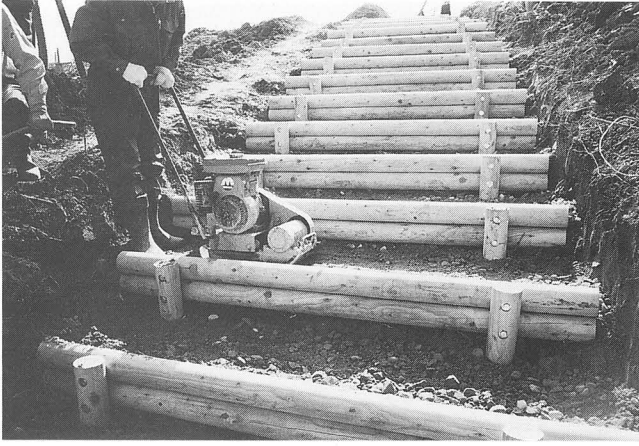
園路階段工事
