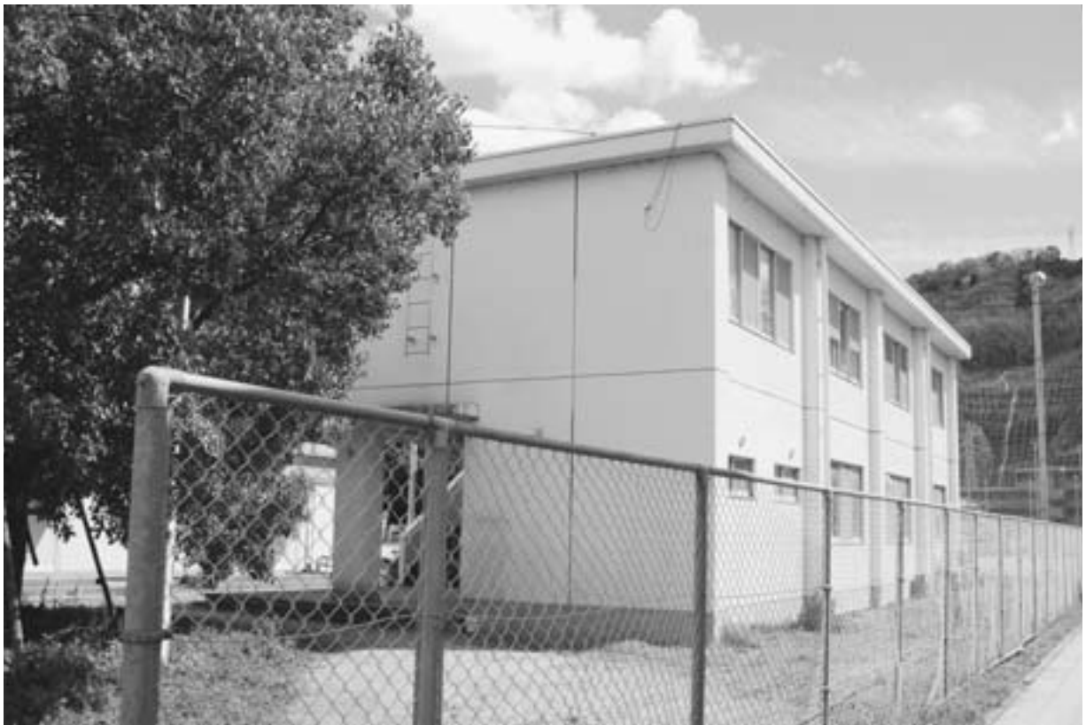
課外活動共用施設の現状（北西より）
