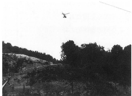
写真2 空中撮影風景
