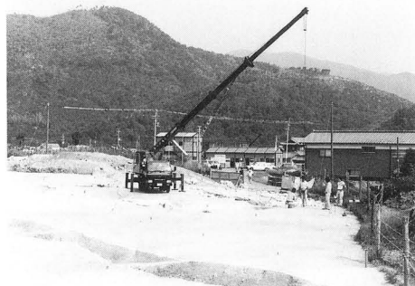
写真3 平成3年度調査クレーン撮影風景
