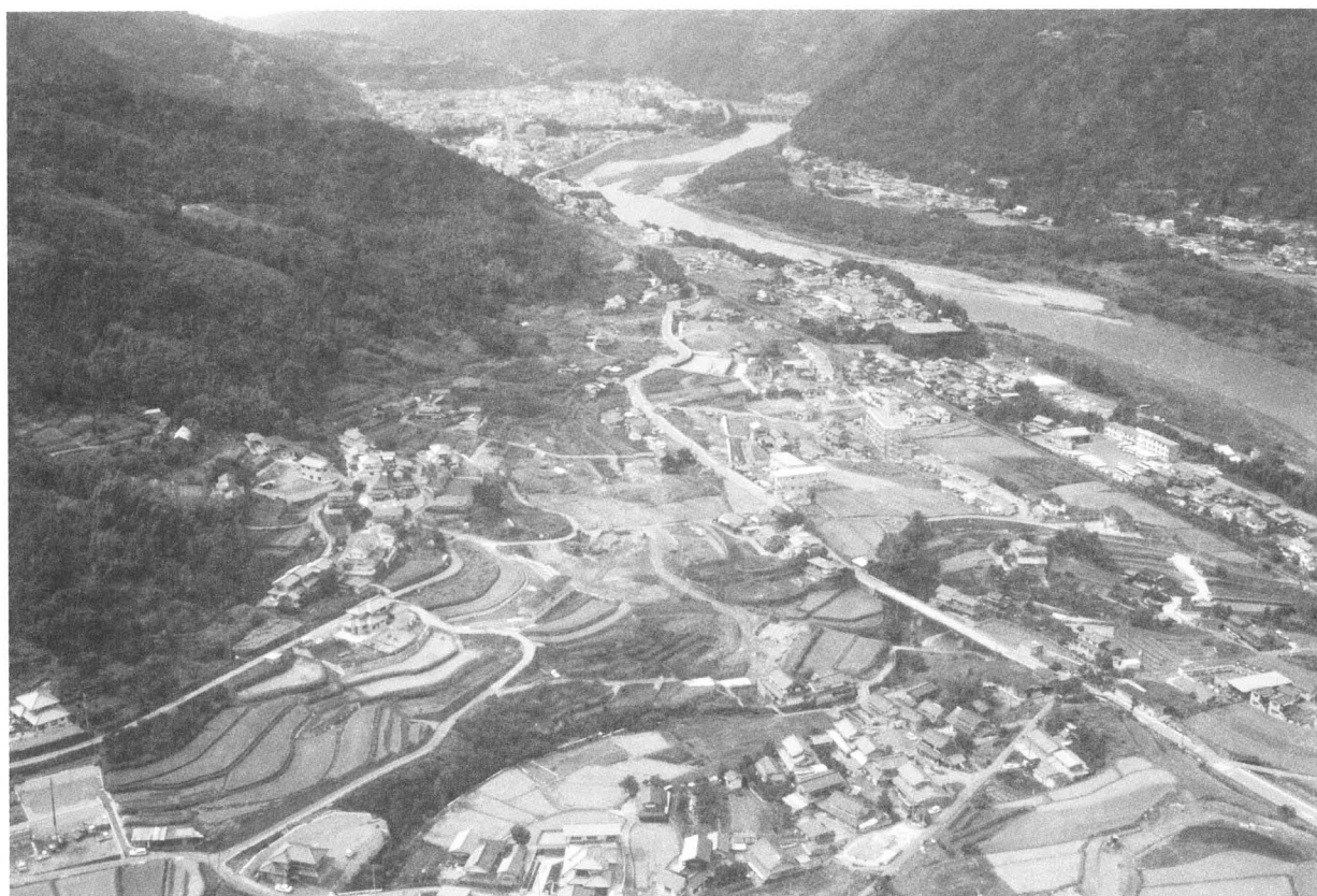
調査地上空より吉野川上流を望む（東から）
