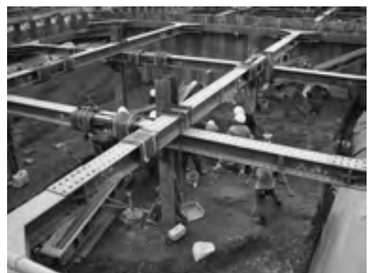
写真8 西川津遺跡 B1 区の遺構精査
