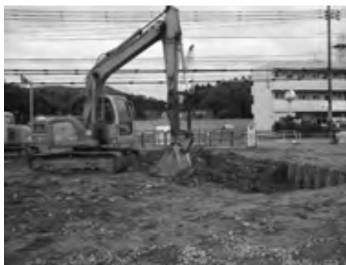
写真3 西川津遺跡 A1 区の表土掘削
