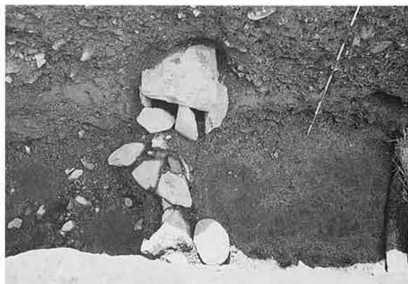
暗渠排水口（東から）
