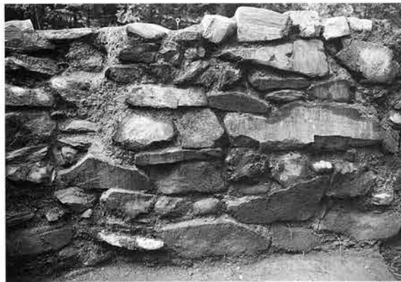
地下構造北壁近景（南から）
