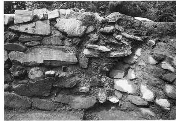
地下構造北～東壁（南から）
