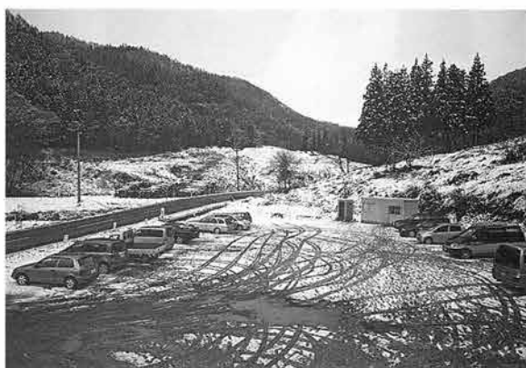
子飼沢高炉跡候補地 (南から)
