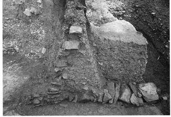
地下構造暗渠排水断面（南から）
