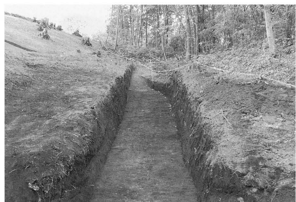
斜面部調査状況 (東から)
