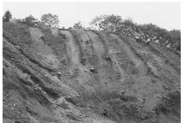
斜面部調査状況 (南から)
