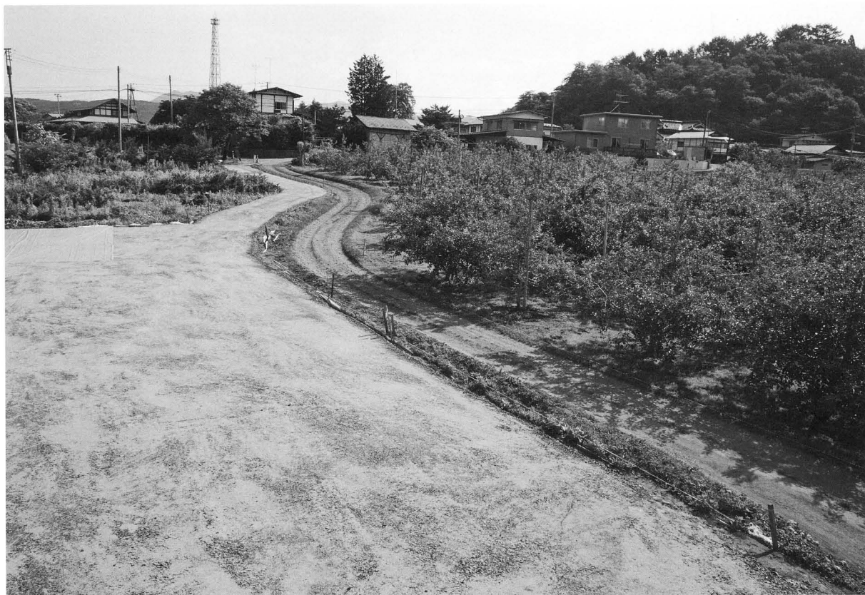
調査前風景（南から）
