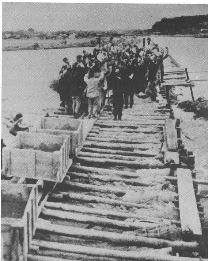
第17図 昭和28年の台風13号で決壊した大田町・川南新田の締め切り工事状況
