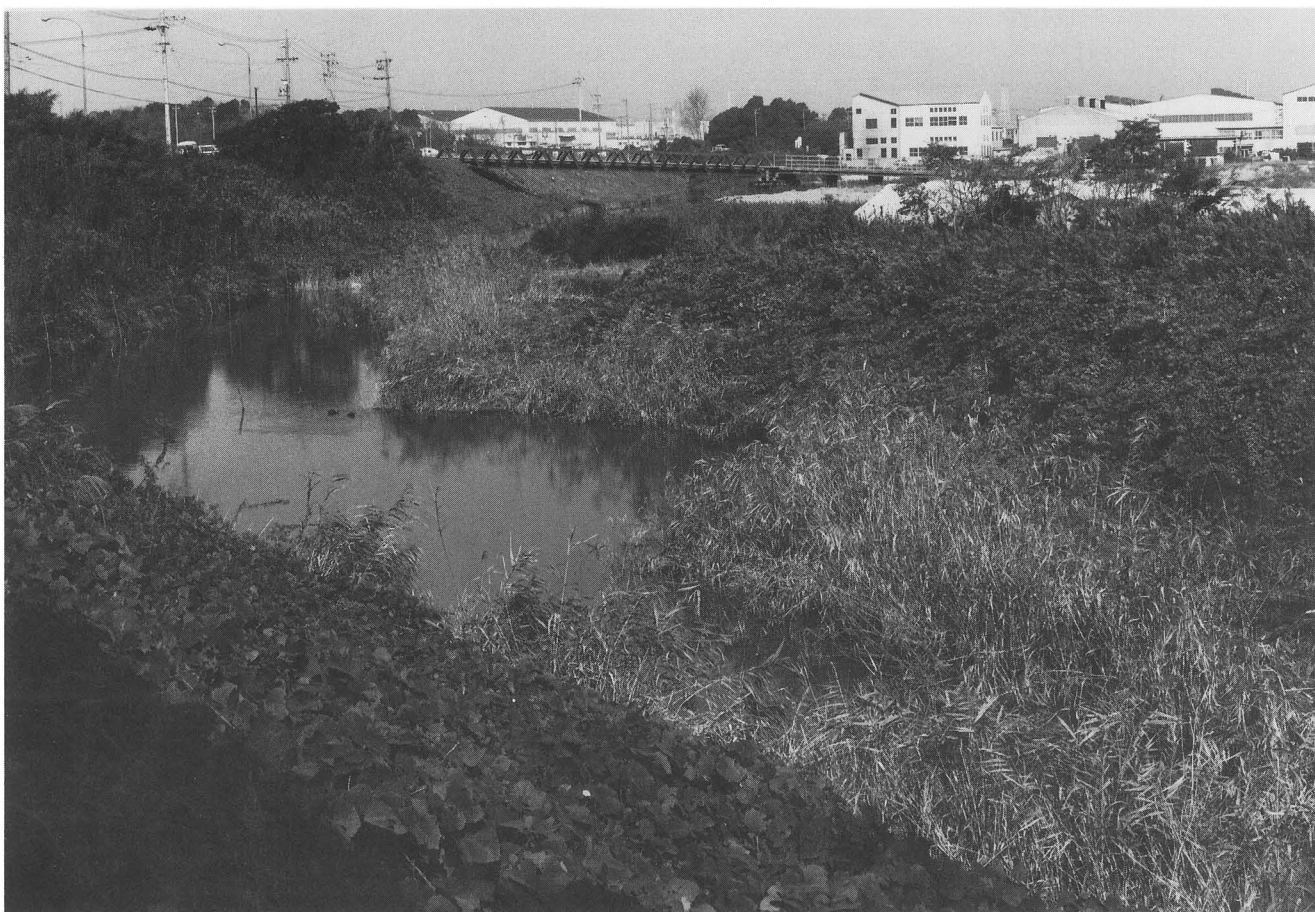
浅山新田堤防 (南から北を望む・1995年)
