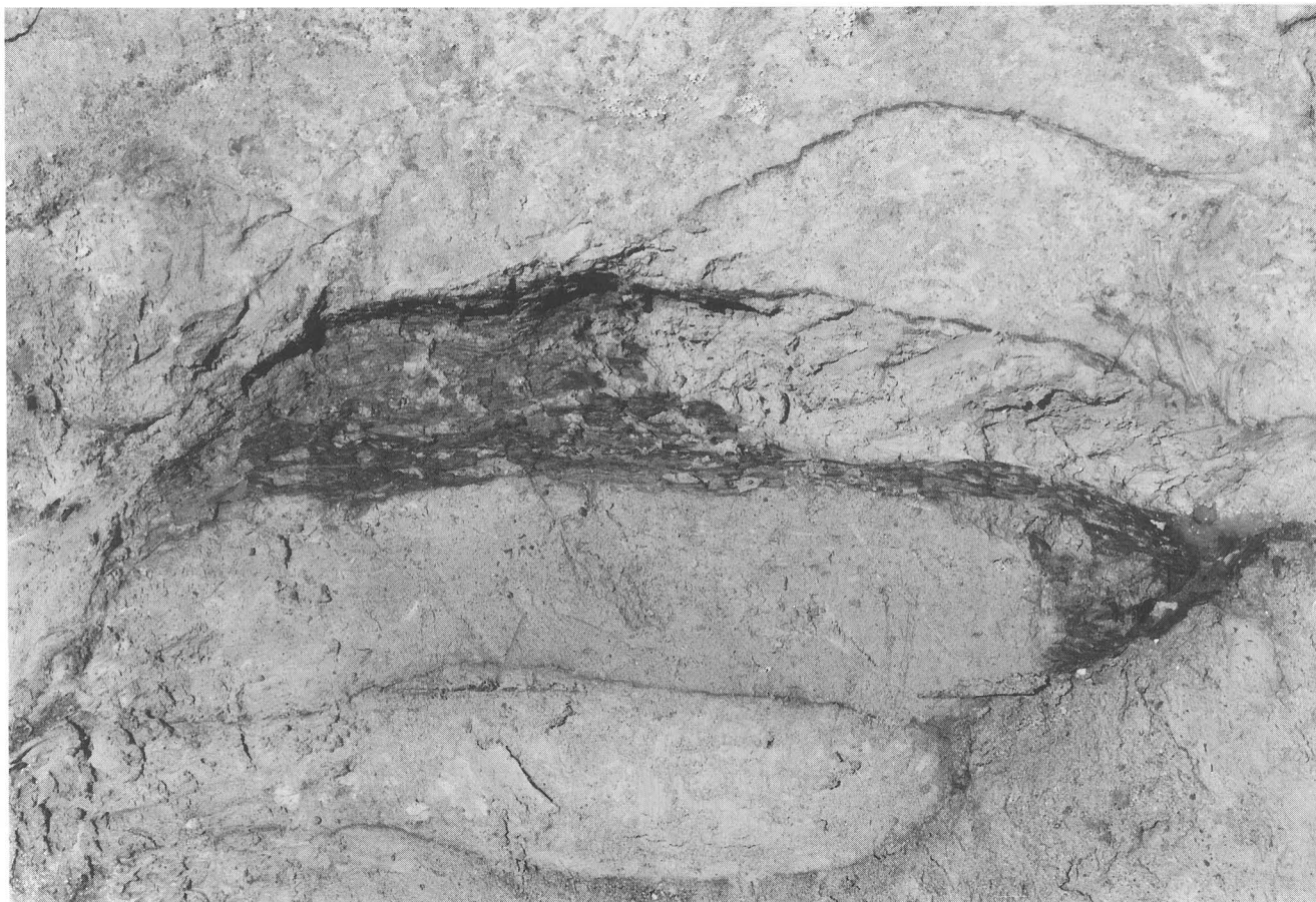
A区北面下端土のう(俵)
