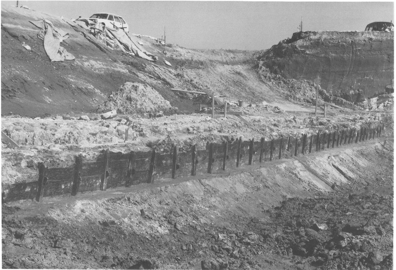
A区北侧区板栅
