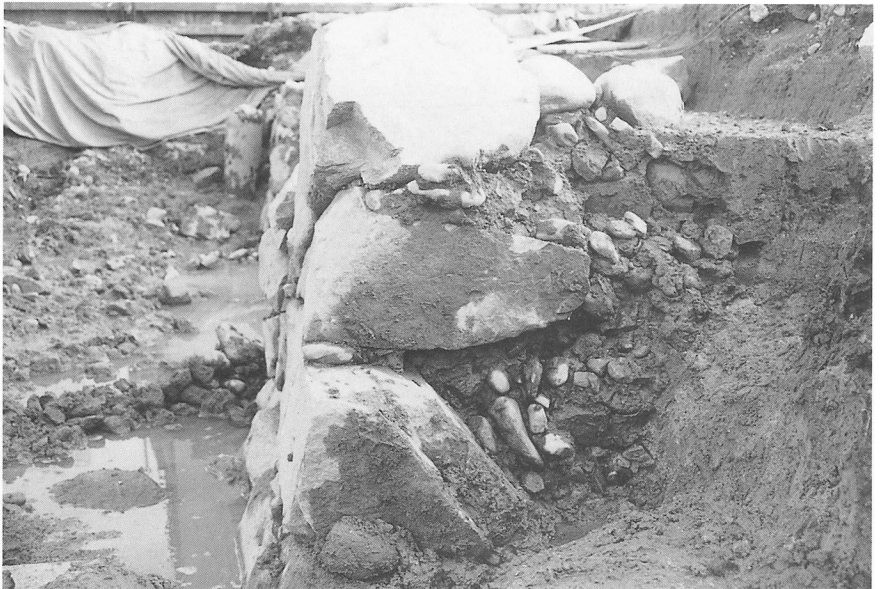
3. 内堀北 I 区の下層石垣断面
