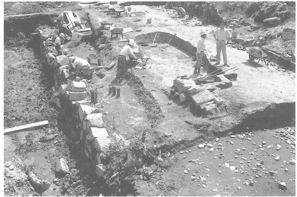
4. 上層石垣解体後の遺構掘り下げ
