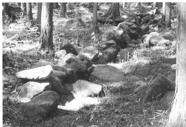
⑦林畑谷左岸・排水路の護岸状の石積
