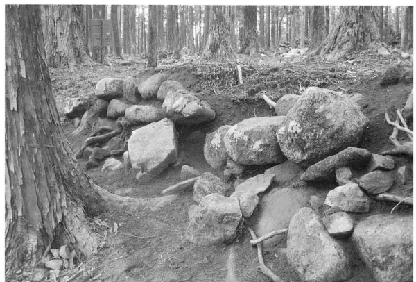
④F区石段東方法面の石積
