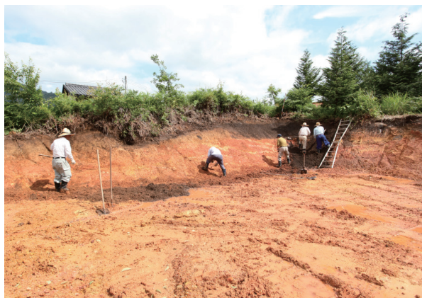
作業状況 (南西から)
