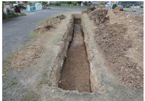
トレンチ 14 断面 (北から)
