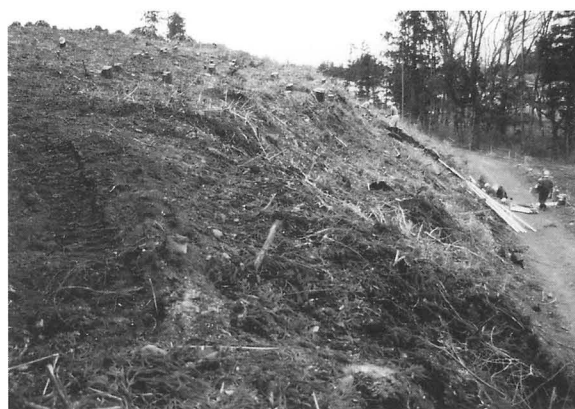
調査前現況（北斜面）
