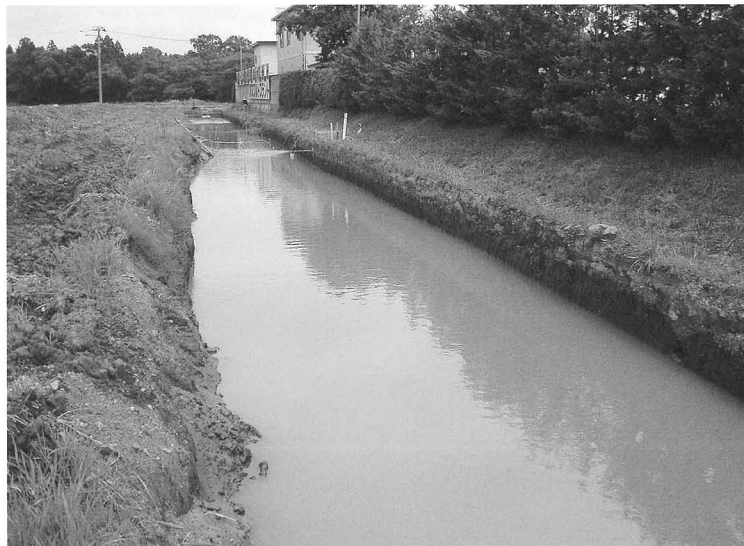
O区全景（南から）
