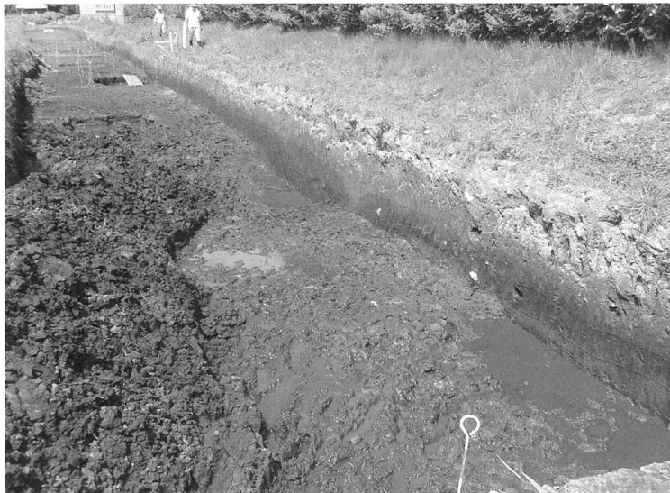
O区全景（南から）
