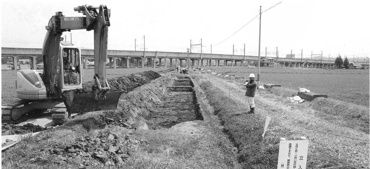
A区重機掘削（西から）
