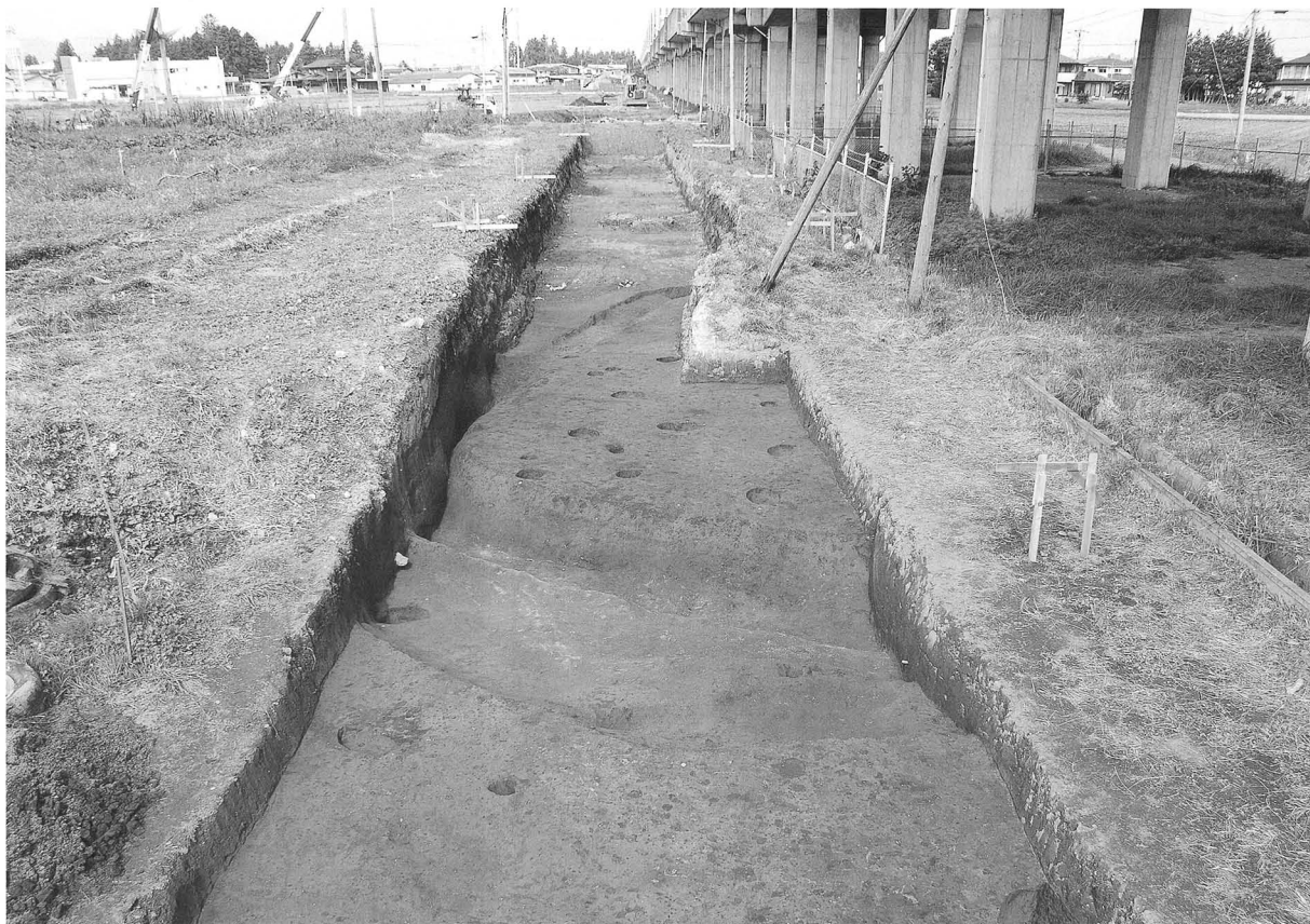
G 3区全景 (南から)
