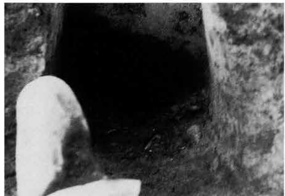
煙道断面（南から）
