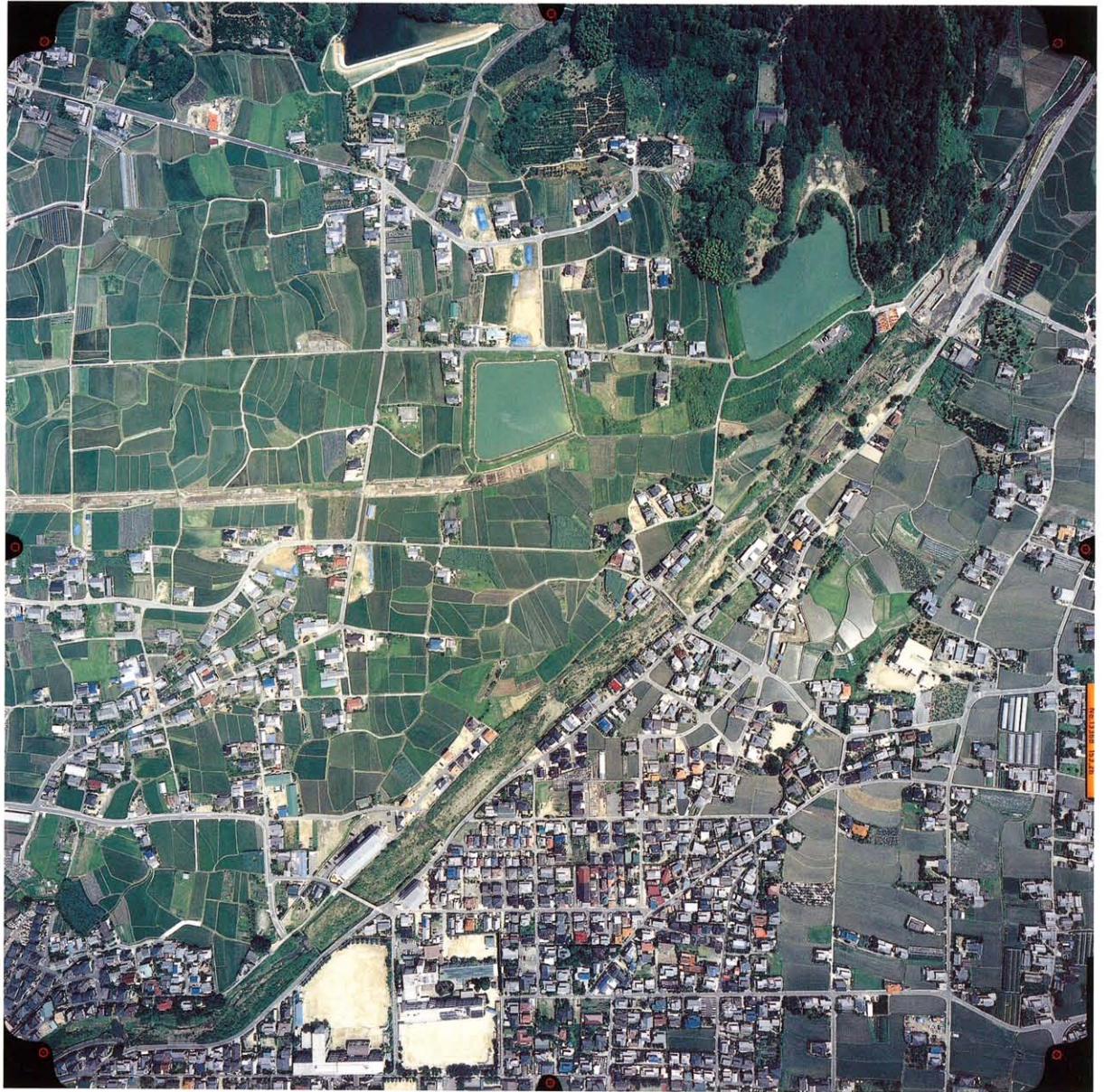
巻頭図版 上空より望む調査地
