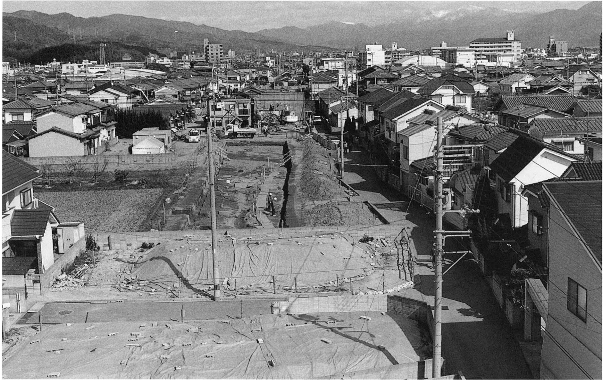
1 調査前全景(西より)
