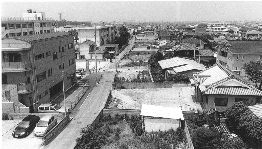
2 調査地全景(2) (東より)
