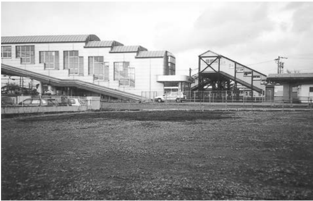
調査地全景 (南西から)
