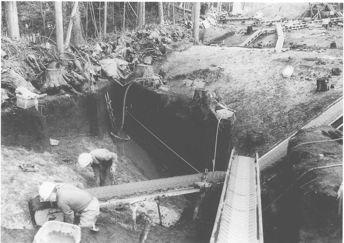
沢B 調査風景 (MQ 73 付近; 西から)
