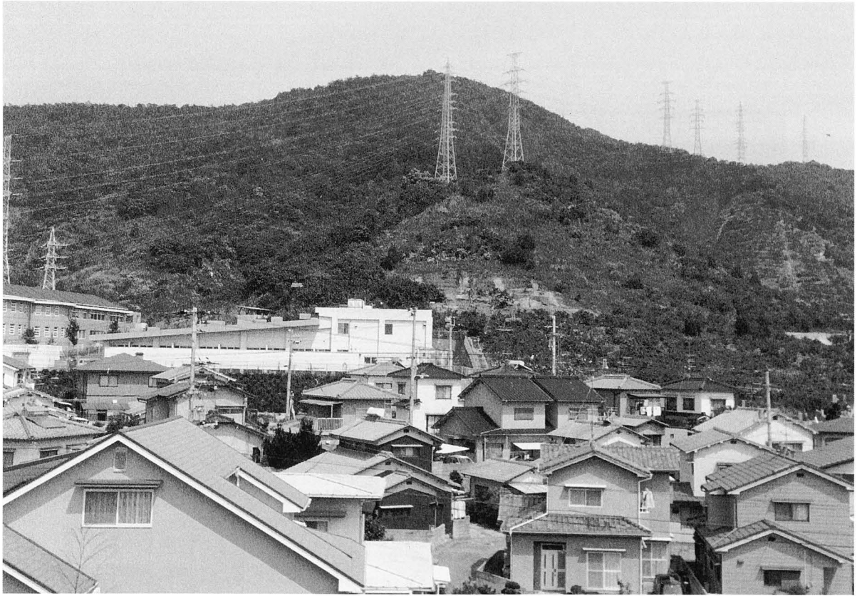
1. 調査地遠景（西より）
