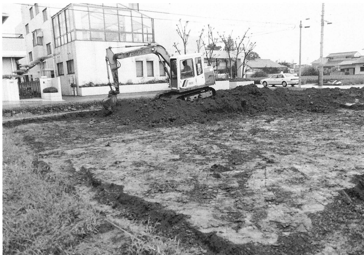
2. 重機による表土剥ぎ取り状況（北西より）
