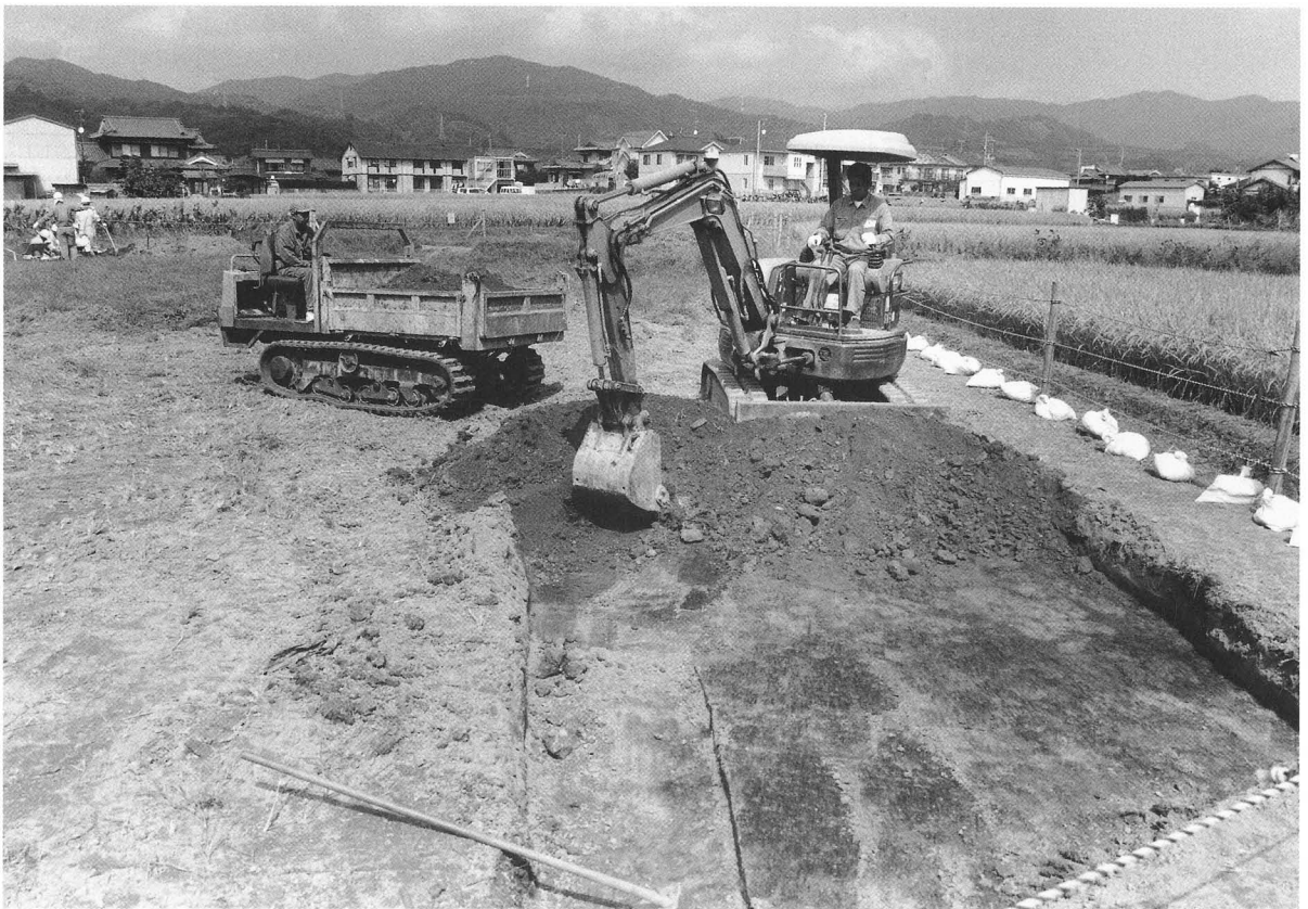
2. 重機による表土掘削（南西より）
