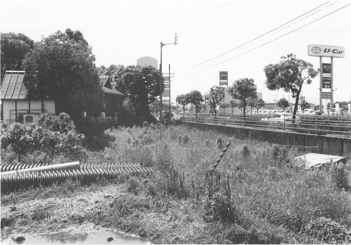
1. 調査前全景（北西より）
