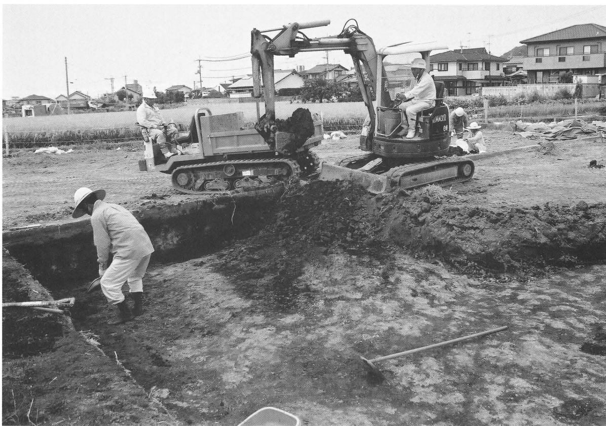
2. 重機による表土掘削（南東より）
