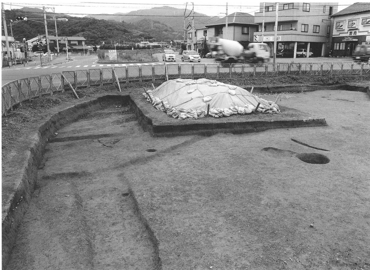
1. 遺構完掘状況（南より）
