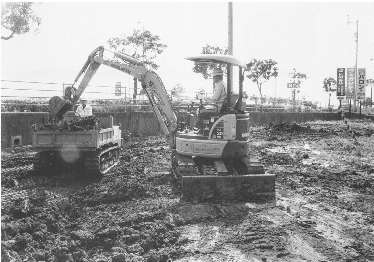
2. 掘削状況（北東より）
