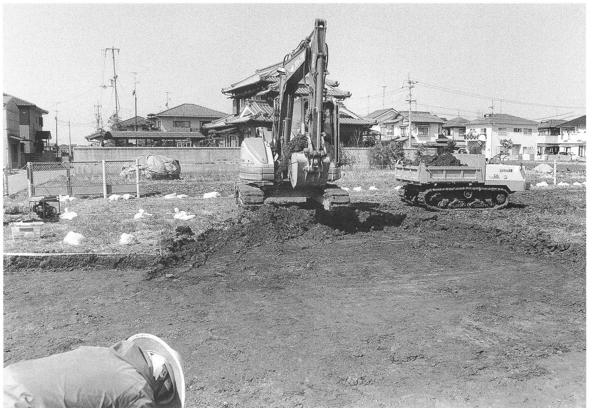
2. 重機による表土掘削（東より）
