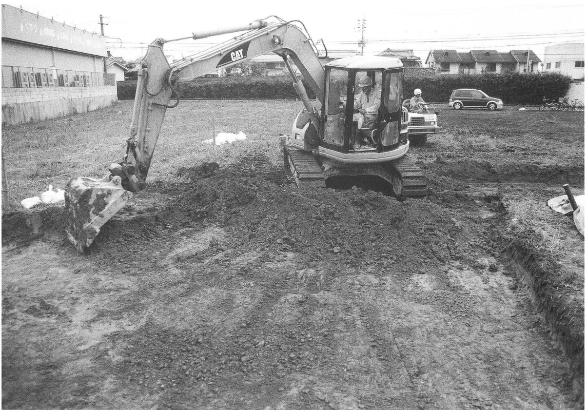
2. 重機による表土掘削（北より）
