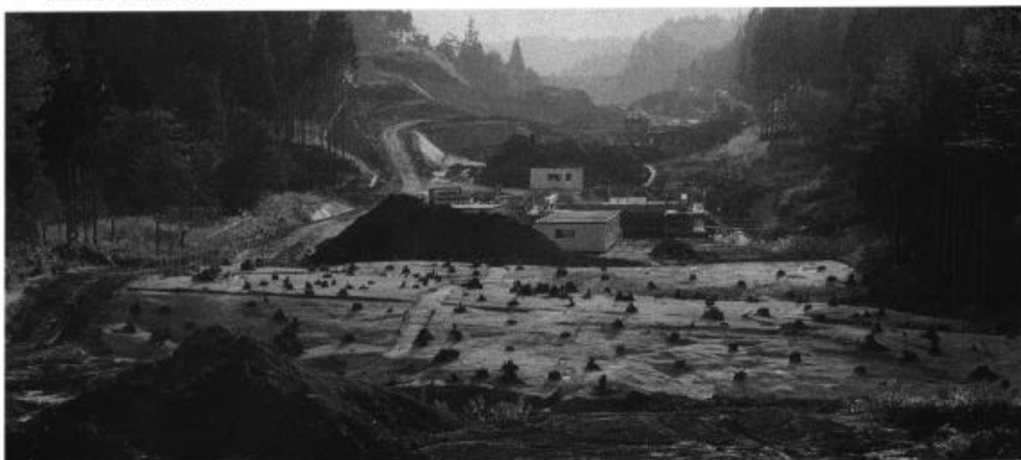
2 調査区遠景(北東から)
