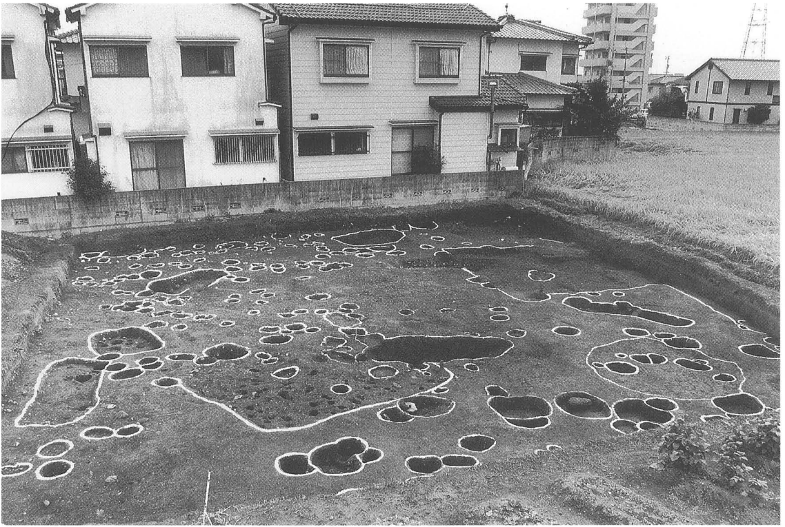
1. 完掘状況①（北より）
