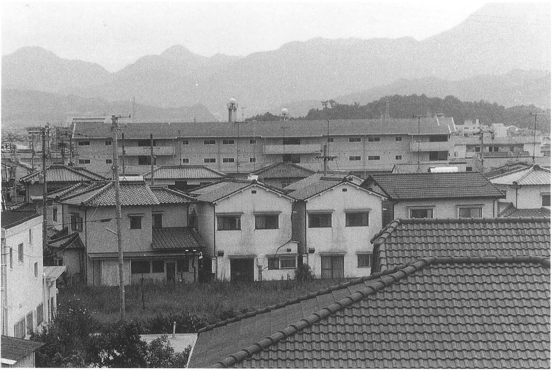
1. 調査前遠景（北より）
